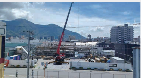
2025年9月3日の「希望のまち」建築現場
